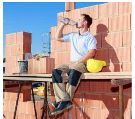
Bauarbeiter im Freien © juefraphoto-stock.adobe.com_113626635
