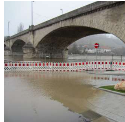
Überschwemmung in Würzburg ©.Stadt Würzburg
