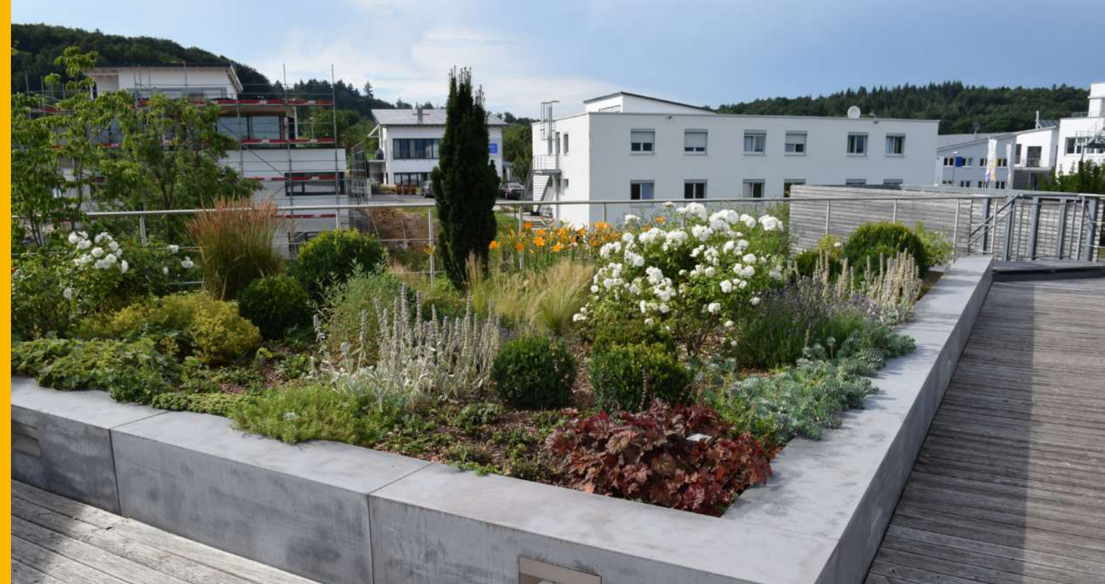
Dachbegrünung als sommerlicher Wärmeschutz für Innenräume © Nürtingen_Zinco
